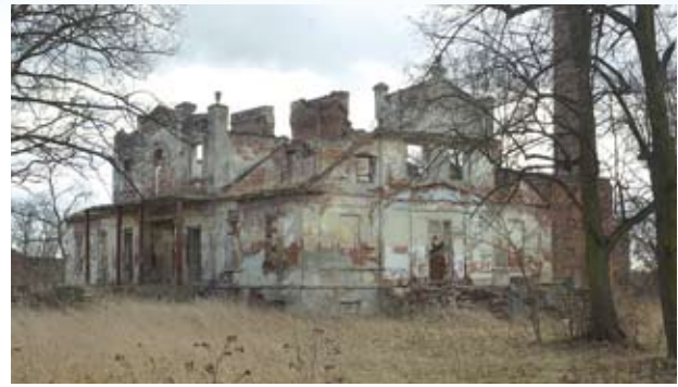
Zniszczony dwór i drzewostan w parku przyfabrycznym w Głinojecku
