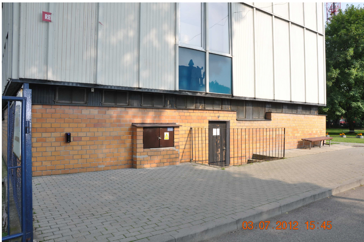
Fragment elewacji zachodniej budynku
