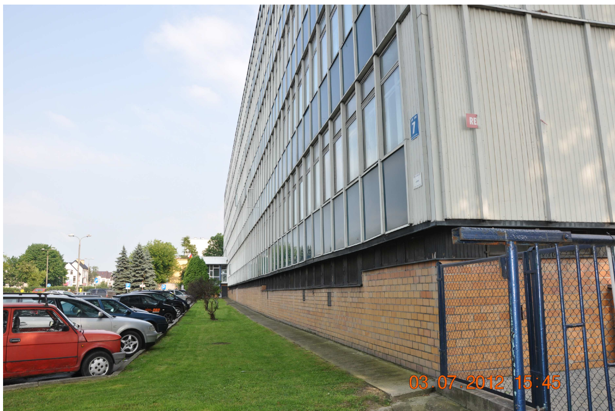
Fragment elewacji północnej budynku
