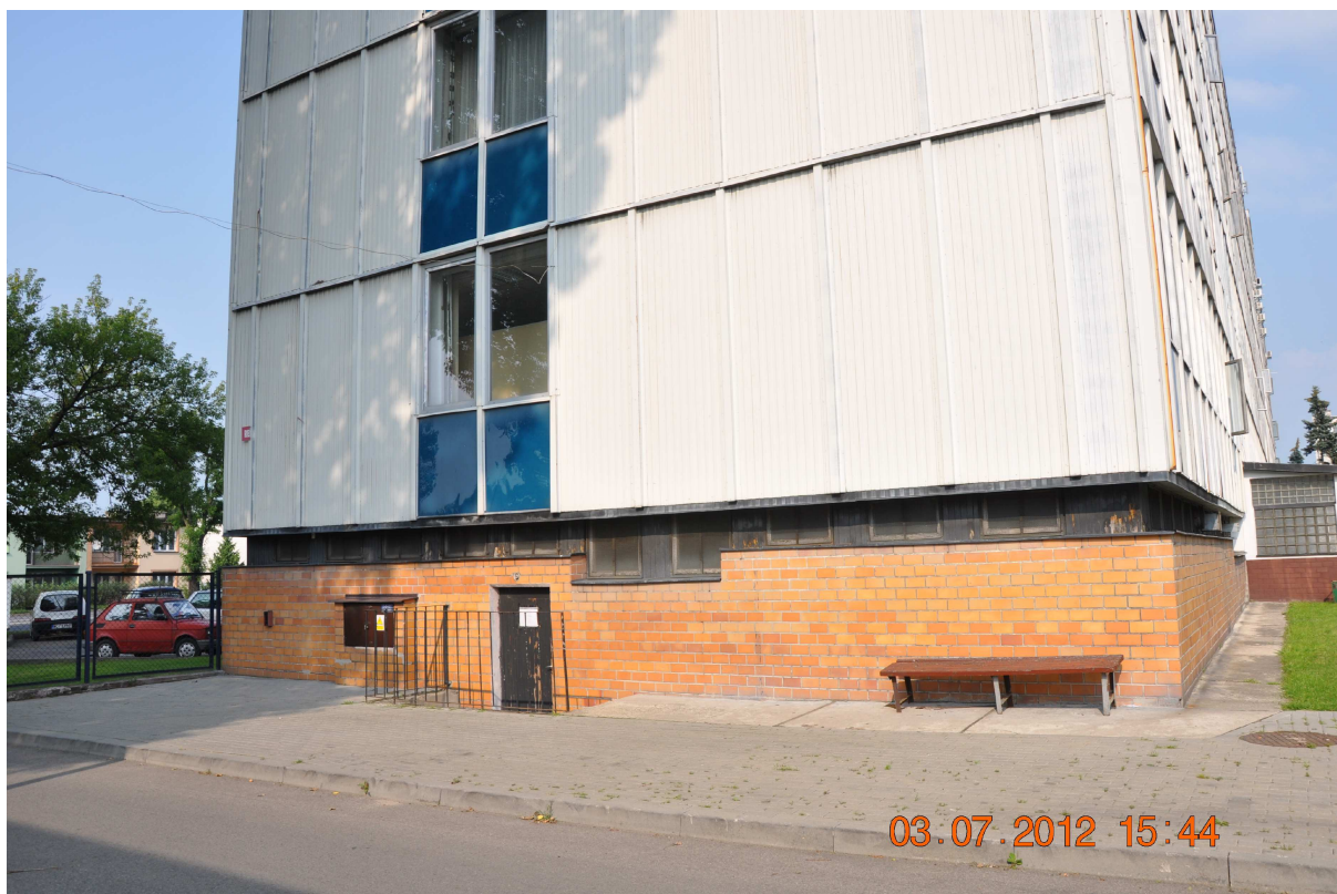
Fragment elewacji zachodniej budynku
