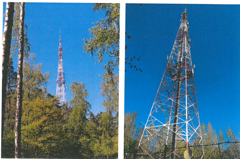
Widok obiektu wraz z zainstalowanym zespołem antenowym
