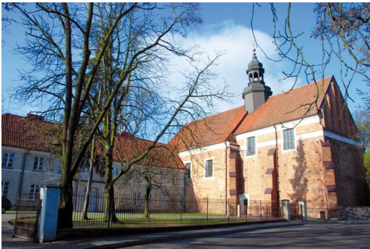
Kościół poklasztorny – elewacja południowa
