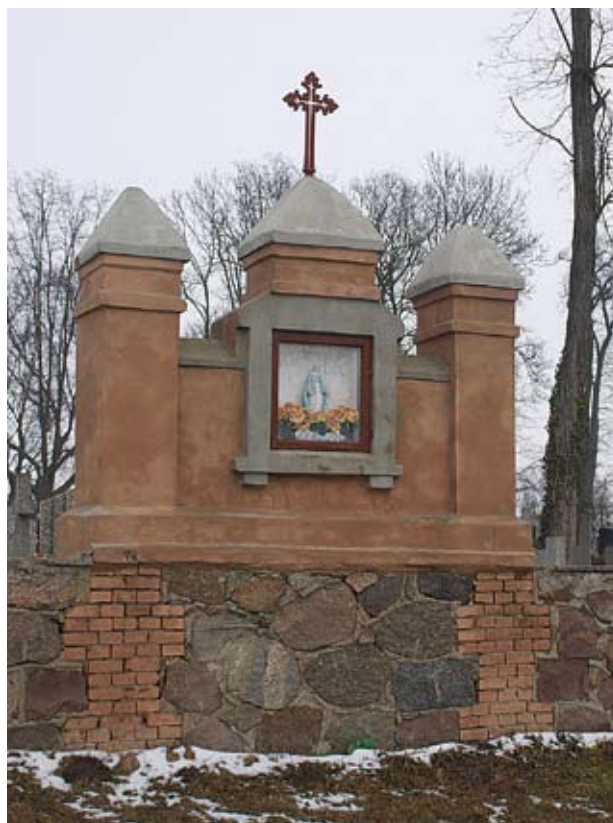
Kapliczka w murze cmentarnym, Lekowo
