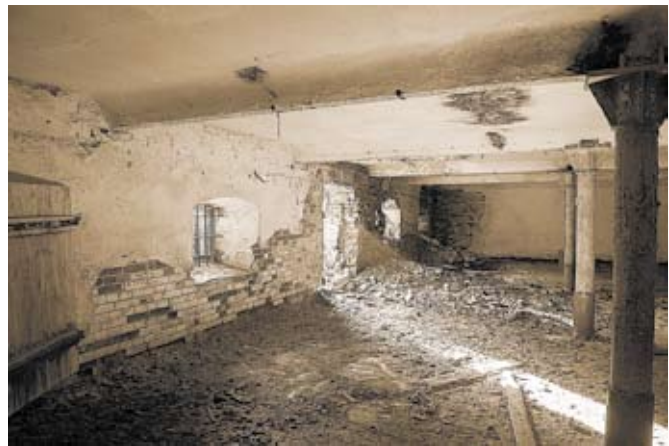
Wnętrze cukrowni Izabelin – stan obecny
