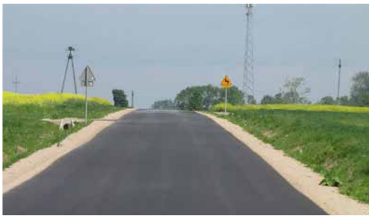
Wyremontowana droga powiatowa Lipa -Dzbonie
