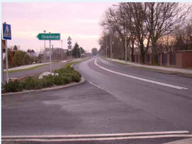
Ulica Sońska w Ciechanowie już po remoncie
