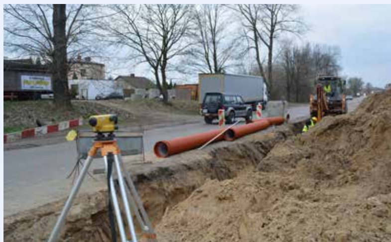
Prace remontowe w ulicy Sońskiej latem 2017 roku
