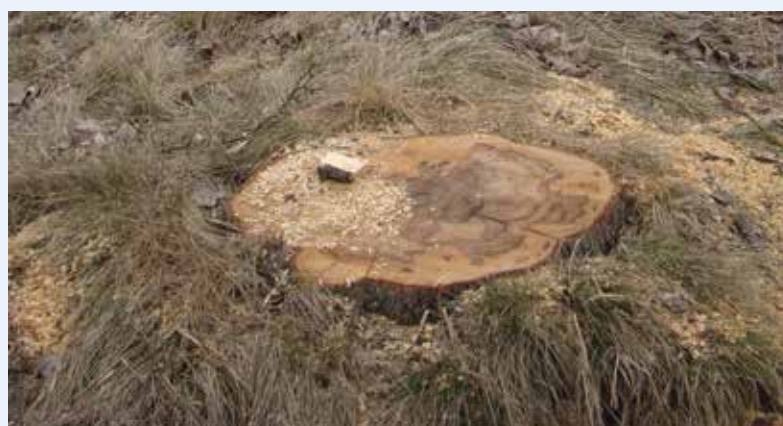
Inwestycja rozpoczęła się od wycinki drzew. W ich miejsce zostały posadzone nowe drzewa i krzewy
