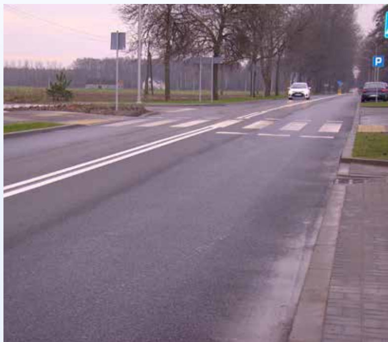
Odcinek drogi w okolicy kąpieliska na Krubinie - po remoncie
