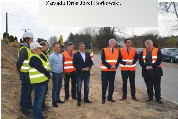
Włodarze powiatu i miasta na placu budowy ulicy Sońskiej w Ciechanowie
