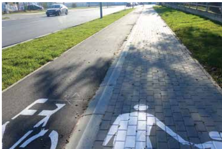
Ulica Mazowiecka po remoncie
