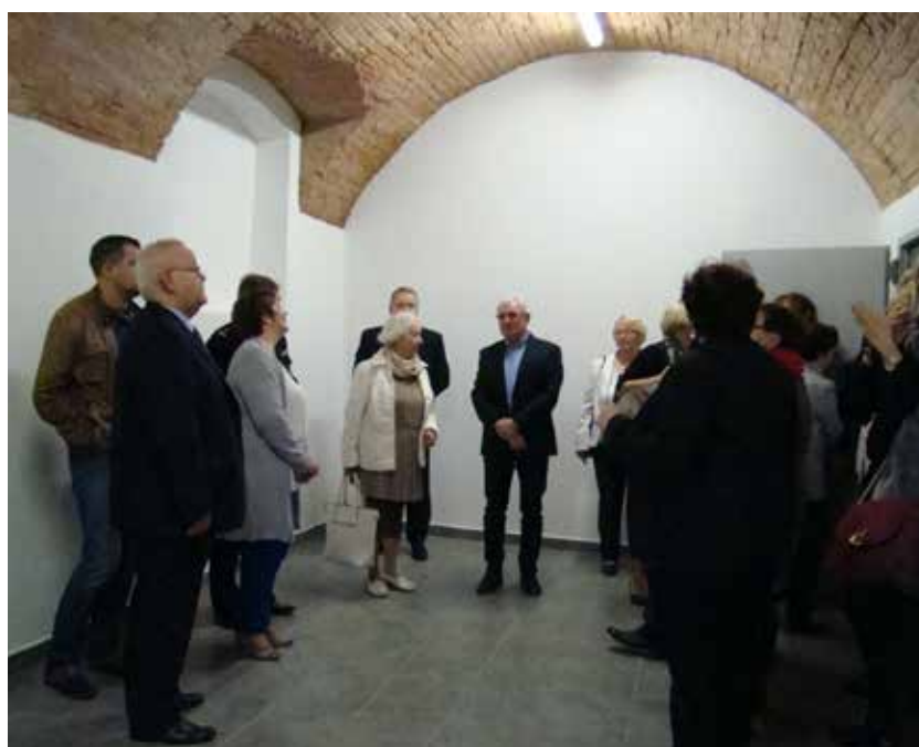
Jedno z pomieszczeń z zabytkowymi sklepieniami w piwnicach budynku Polonii
