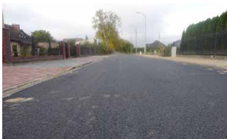
Ulica Kwiatowa w Ciechanowie tuż po położeniu asfaltu
