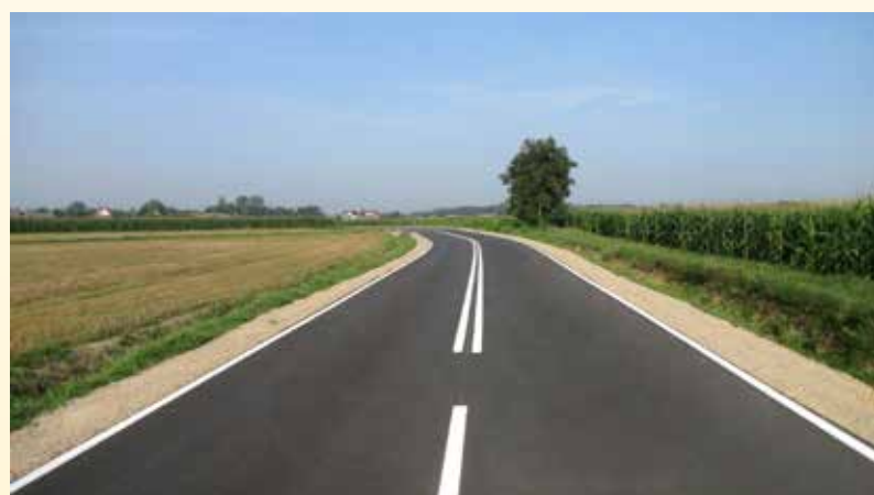
Przebudowana droga z Ciechanowa do Młocka
