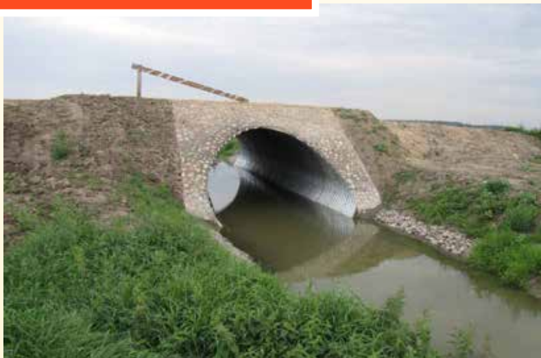
Przebudowywana droga z Ciechanowa do Opinogóry przez Kąty
