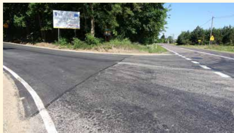
Przebudowana droga Pniewo-Czeruchy
