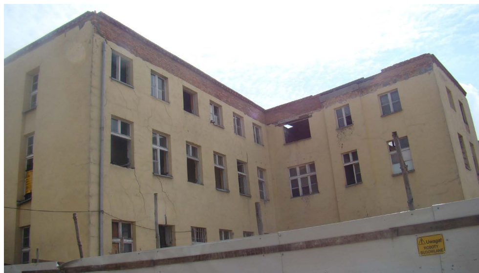
Prace remontowe budynku przy ulicy Warszawskiej
