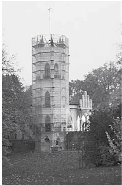
Zameczek w trakcie prac remontowych
