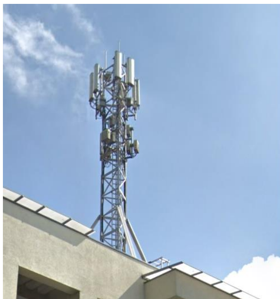
Rysunek 6. Stacje bazowe telefonii komórkowej na dachu budynku oraz wolnostojąca
