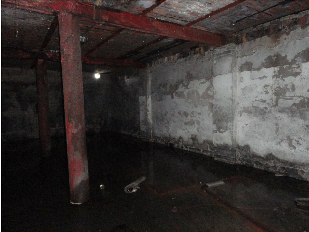
Wnętrze składu węgla - stalowa konstrukcja podpierająca i strop ceramiczny
