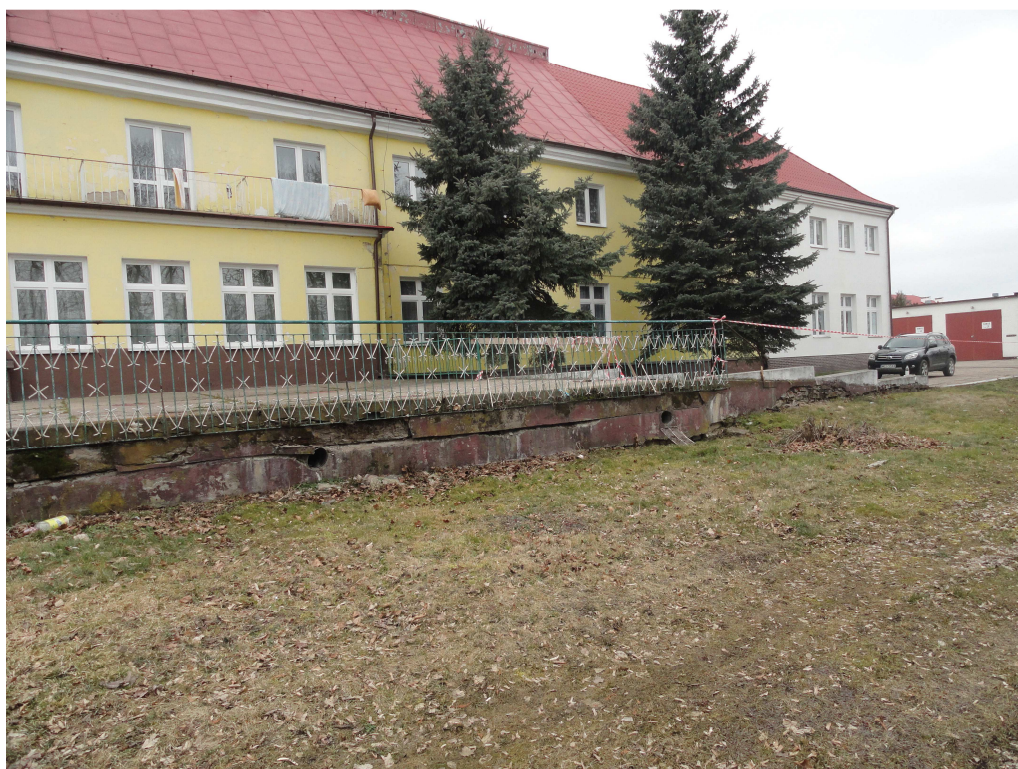
Droga dojazdowa i plac betonowy na stropie składu węgla.
