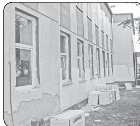
Przebieg remontu elewacji w ZST w Ciechanowie
