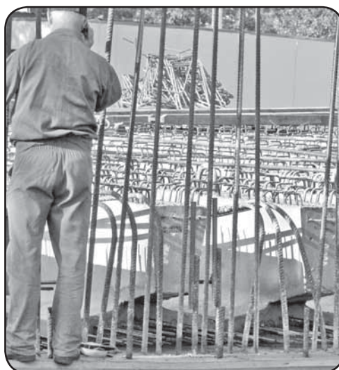
Prace związane z palowaniem żelbetonowych elementów, podpory mostu
