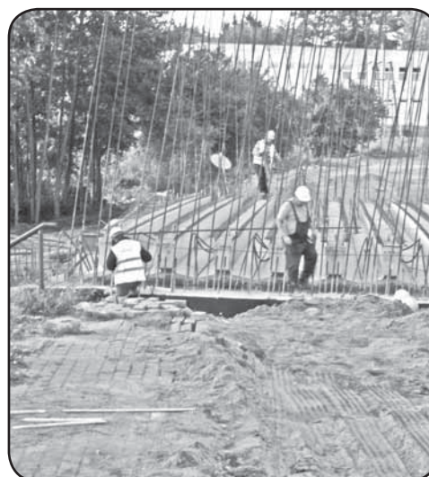
Prace związane z palowaniem żelbetonowych elementów, podpory mostu
