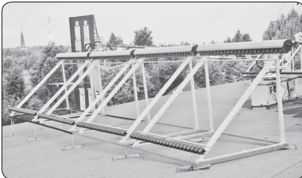
Nowe solary, zamontowane na dachu, zmniejszą koszty podgrzania wody
