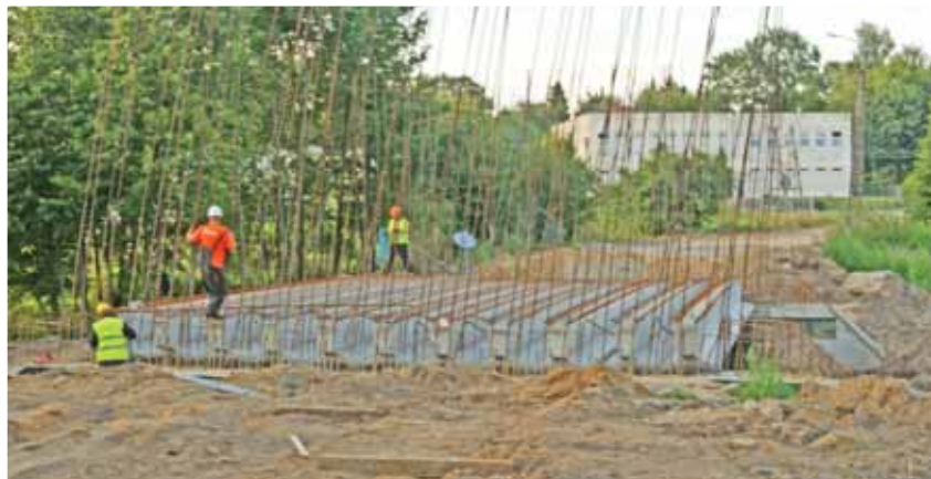
Budowa mostu w Lekowie zbliża się ku końcowi
